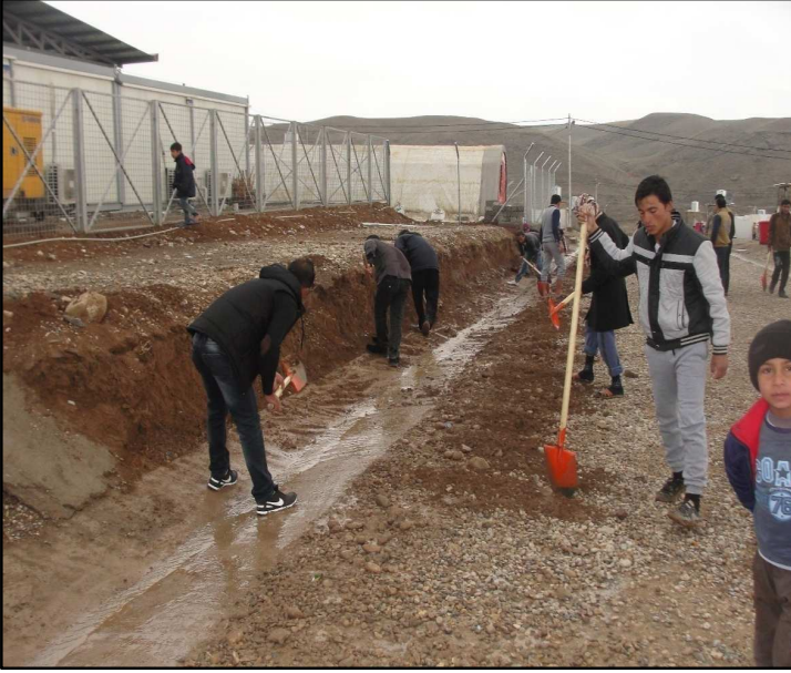
( أثناء تنظيف قناة صرف المياه في المخيم )
